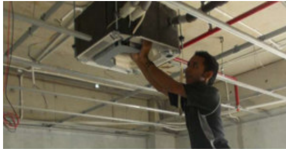
Pemasangan Indoor AC
