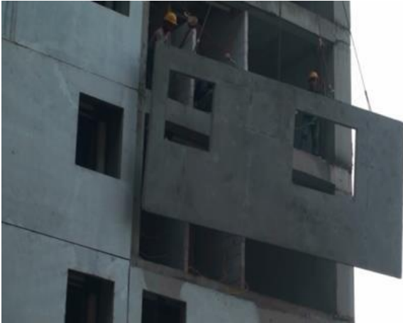
Penggunaan Material Precast untuk mengurangi sampah konstruksi
