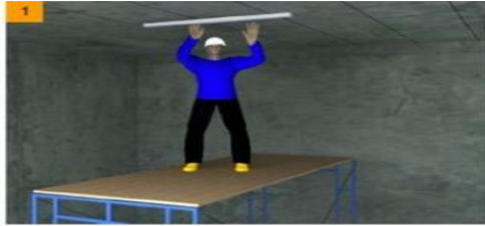
Marking leveling dan menentukan posisi kawat penggantung
