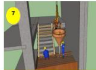
Pekerjaan pengecoran tangga
