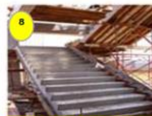
Pekerjaan Curing Beton
