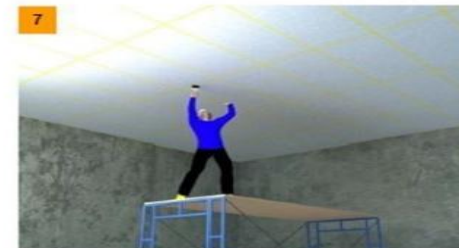
Perapihan Sambungan Material Plafond dengan Compound dan papertape finishing dengan cat dan pemasangan list plafond
