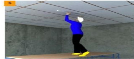
Cek Kerataan permukaan Material Plafond dengan Jidar Aluminium
