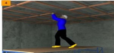
Pasangan Rangka Plafond
