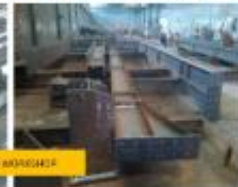
Perakitan Elemen Struktur Baja
