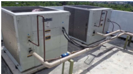
Pemasangan Outdoor AC
